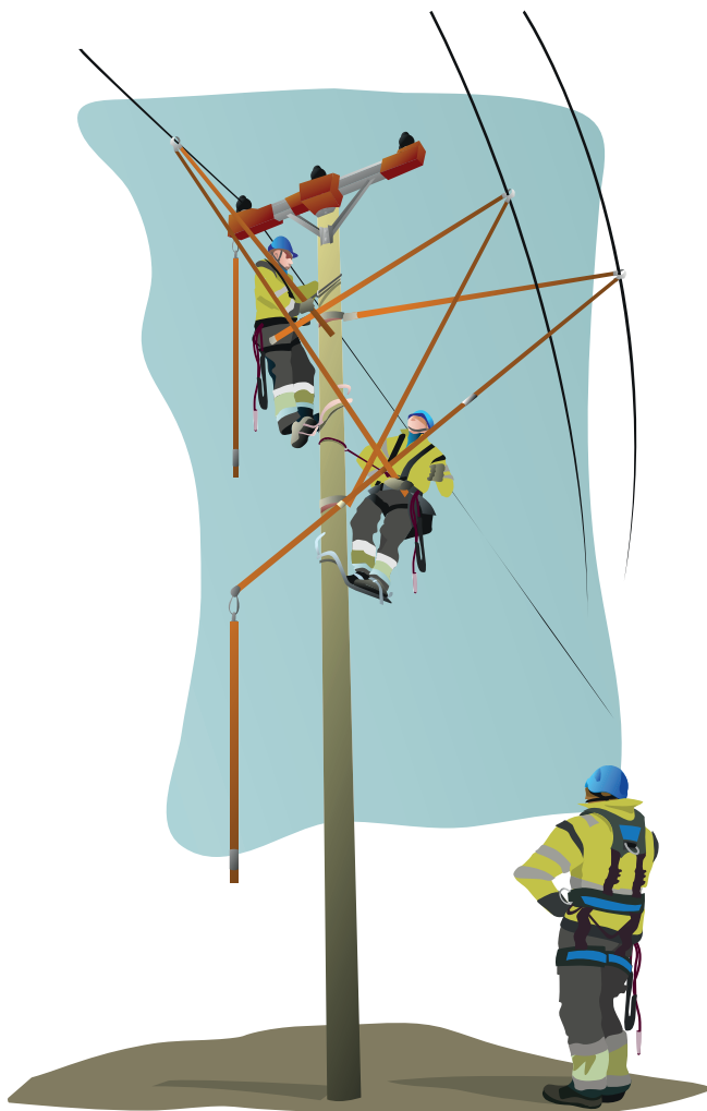
Bild 3. Distributionselektriker utför alla förekommande arbeten på elanläggningar som omfattar ny- och ombyggnadsarbeten samt drift och underhåll.
