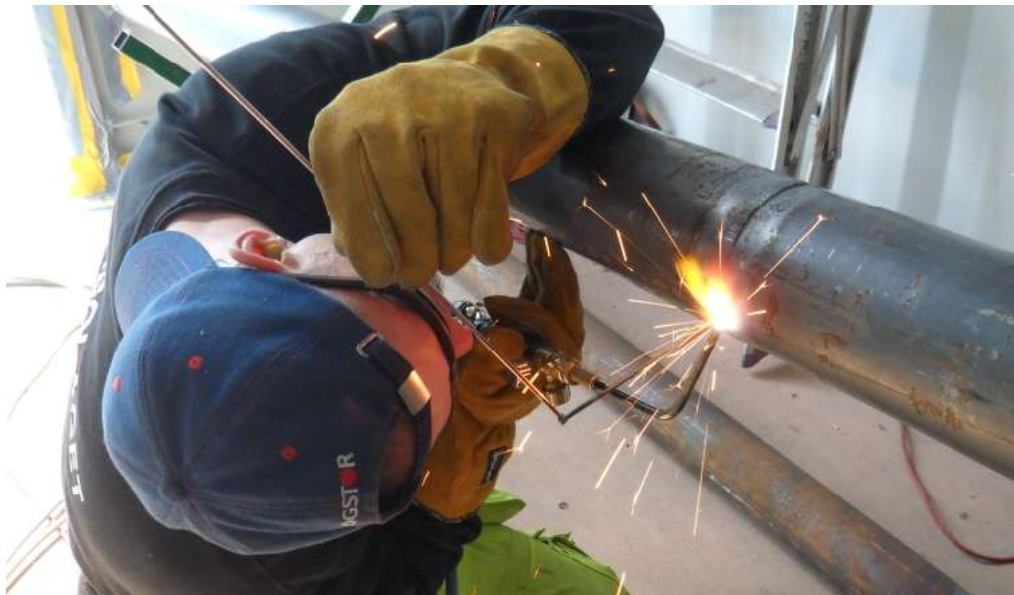
Bild 3. Gassvetsning av stålrör.
