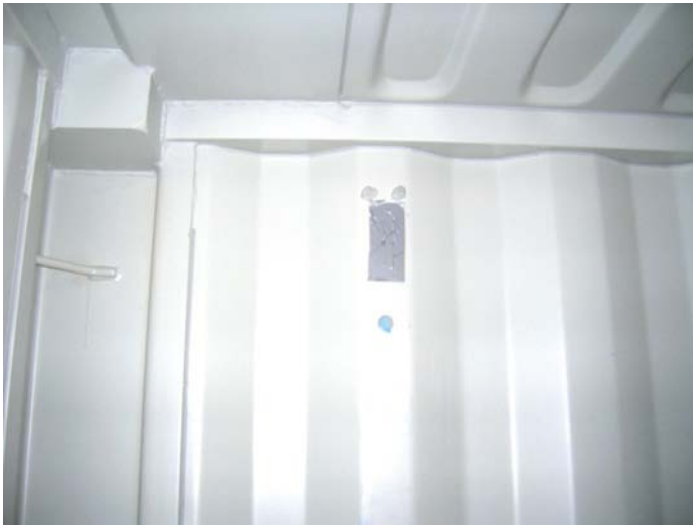
Bild 13, ovan. Igentejpade hål. Dessa hål fanns på fler ställen o i containerns väggar.
