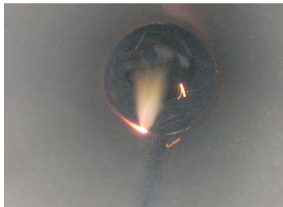
Bild 2. Svetslåga i samband med skarvsvetsning. Under svetsningen sker förbränning av acetylen även i röret. Samma typ av rör som bild 1.
