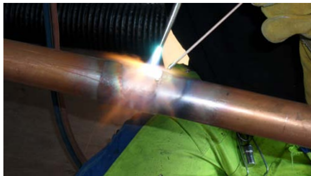
Bild 19, ovan. Lödning med silverkopparrlod.
