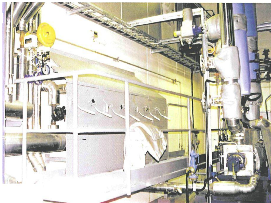
Bottenblåsningsstation vid kraftverkspanna
