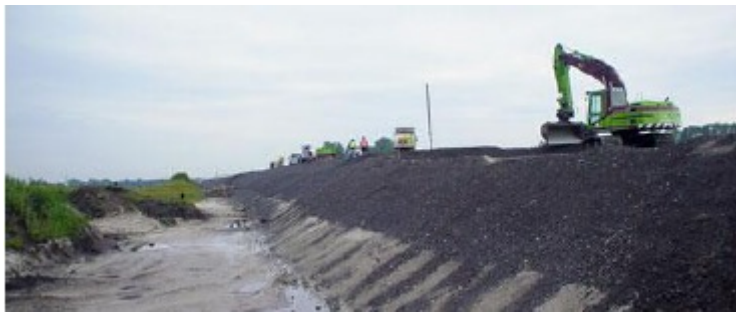
Figur 2 Byggnation av bullerskydd i Nederländerna. Källa: CEWEP (2012).
