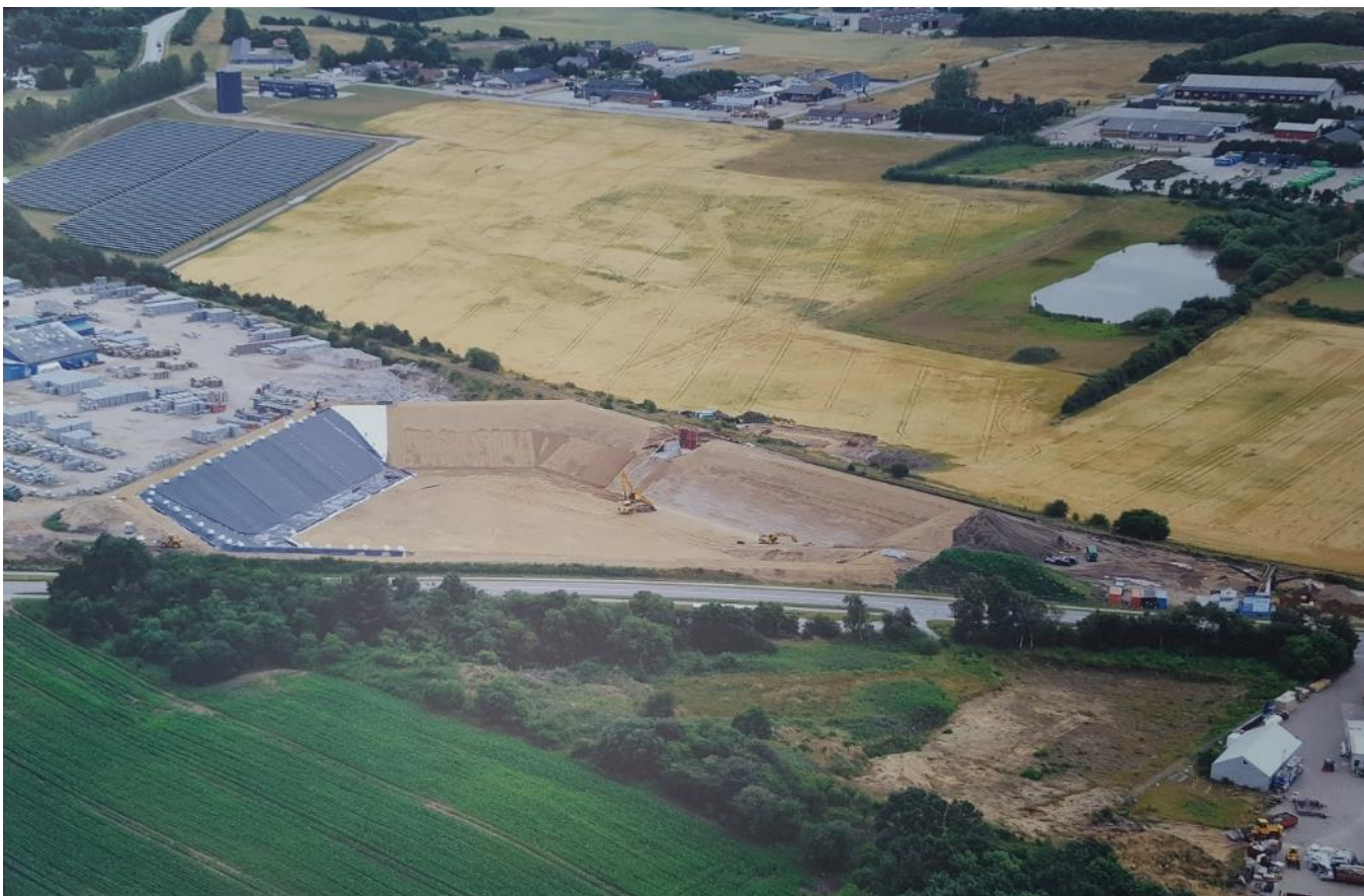
Vojens gropvärmelager, Danmark södra Jylland - Solvärme
