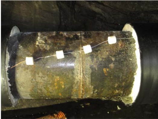
Bild 5. Tråddragning i skarv
