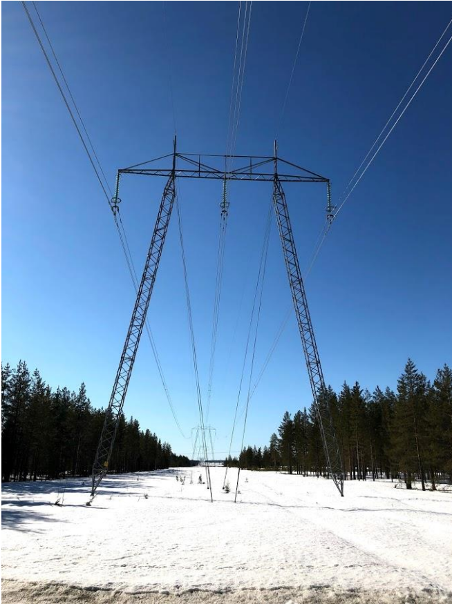
Transmissionsnätledning 400kV
