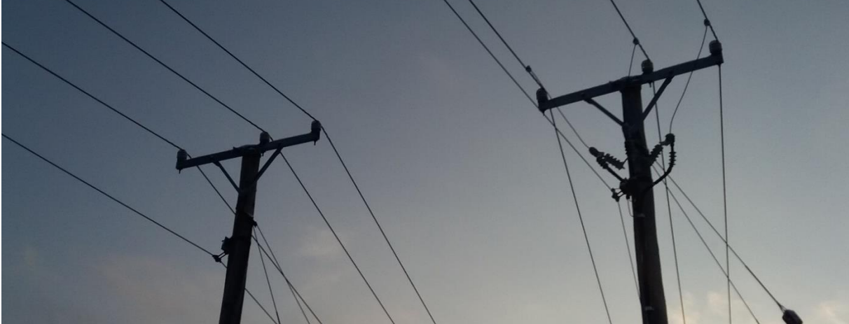
Figur 12. Samma typ av lokalnätsstolpe som i figur 11 med stående isolatorer. Här kan dock ses att faslinorna sitter asymmetriskt, dvs. att två faslinor sitter närmare varandra vilket ger ett kortare avstånd mellan strömförande delar. Konstruktionen är av äldre typ. Till vänster synes en lina under faslinorna, en s.k. längsgående jordlina. I utländska studier benämns den ofta neutralledare.
