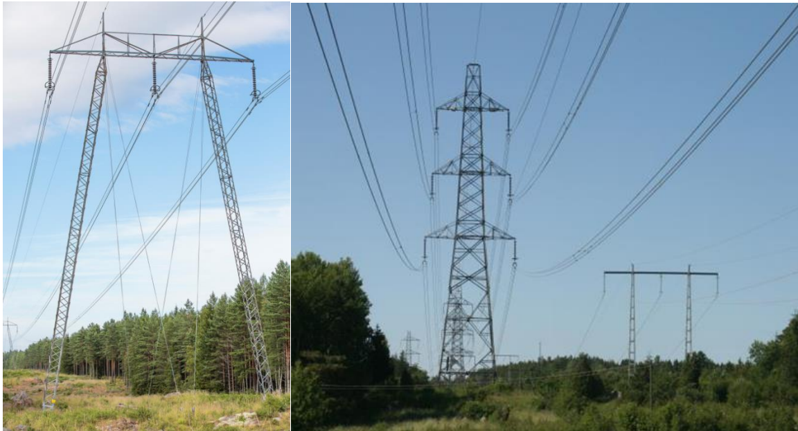
Figur 6 och 7. Exempel på vanlig portalstolpe med ben i fackverkskonstruktion till vänster (figur 6). Stolparna kan vara stagade eller ostagade. Transmissionsnätet har alltid topplina som är tunnare. På bilderna är det tydligt att flera tätt sammankopplade linor hänger i varje isolator. Till höger (figur 7) en s.k. julgrans- eller kompaktstolpe med vertikalt hängande faslinor. Här är det alltså två ledningar, dvs. sex faser som sitter i stolpen. Även här kan man också tydligt se att på varje isolator hänger flera faslinor tätt tillsammans. Till vänster i julgranstolpen hänger två linor = duplex. Till höger hänger tre faslinor på varje = triplex.
