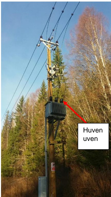
Figur 13 och 14. En nybyggd lokalnätstolpe med stolptransformator till vänster (figur 13). Transformatorns strömförande delar på ovansidan är skyddad med Huven Uven . Linorna upp till faslinorna (slackarna) är isolerade och fasavståndet är kort. De isolerade plastöverdragna linorna har en grön färgton, men de kan också vara svarta eller blåaktiga. Till höger (figur 14) en äldre stolpe med motsvarande konstruktion. Strömförande delar är inte skyddade och faslinorna består av blanktråd.
