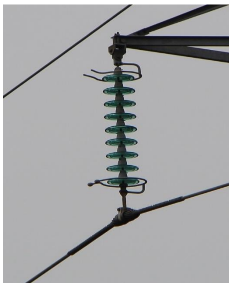
Figur 5. Detalj på isolator som i detta fall hänger nedåt från regeln och utgörs av glasskivor, keramiska skivor eller något gummimaterial. Längden är ofta flera meter på ledningar med högre spänningar. Ju högre spänning desto längre isolator. På stolptyper med stående isolator kan höjden variera mellan ca 20–80 cm.
