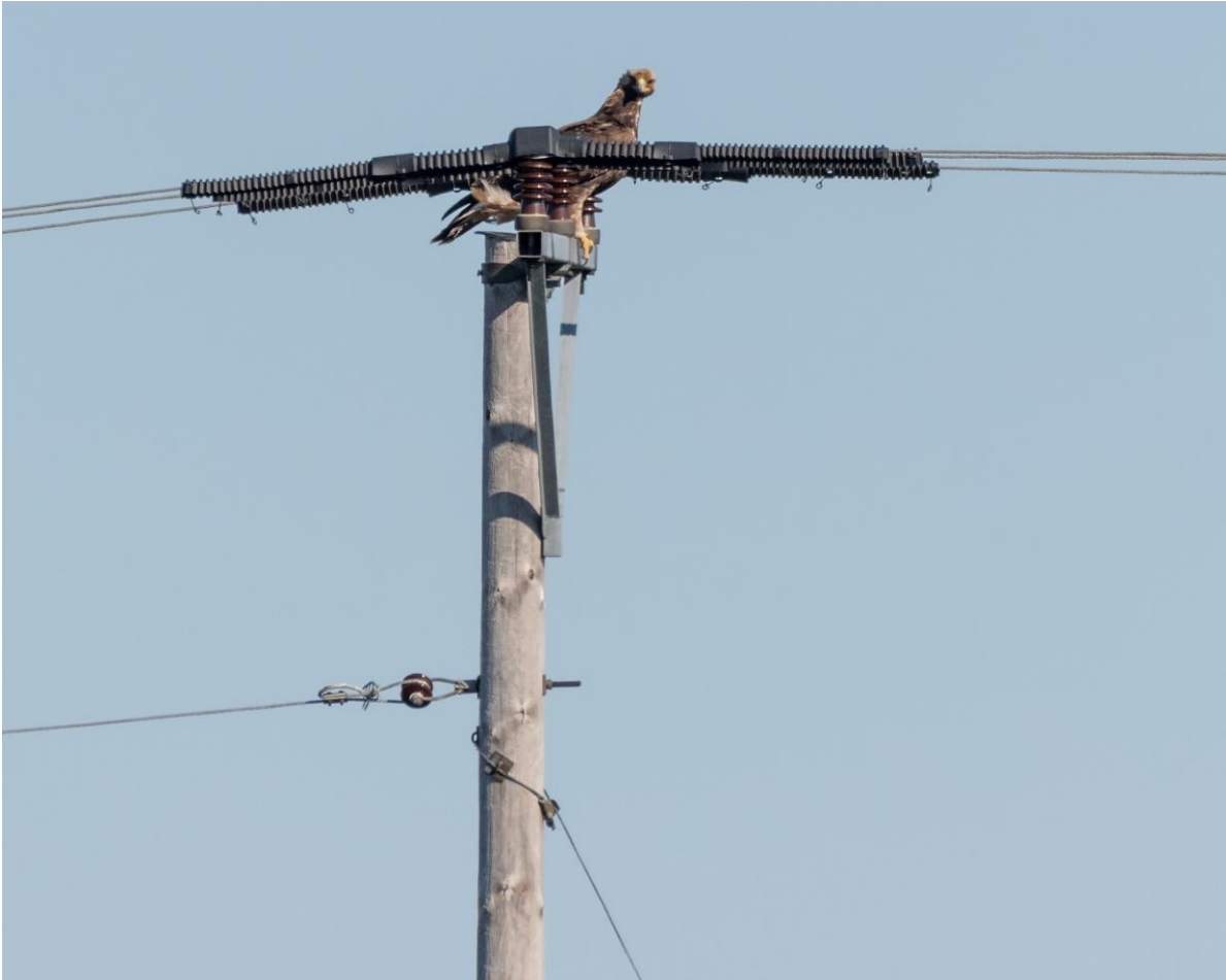
Figur 23. Isolerande plasthöljen över isolatorer på kraftledning på Gotland. Plasthöljet täcker ca 1 m i båda riktningarna från isolatorerna på stolpregeln. Ung kungsörn på stolpregeln. Foto: Fredrik Anmark.
