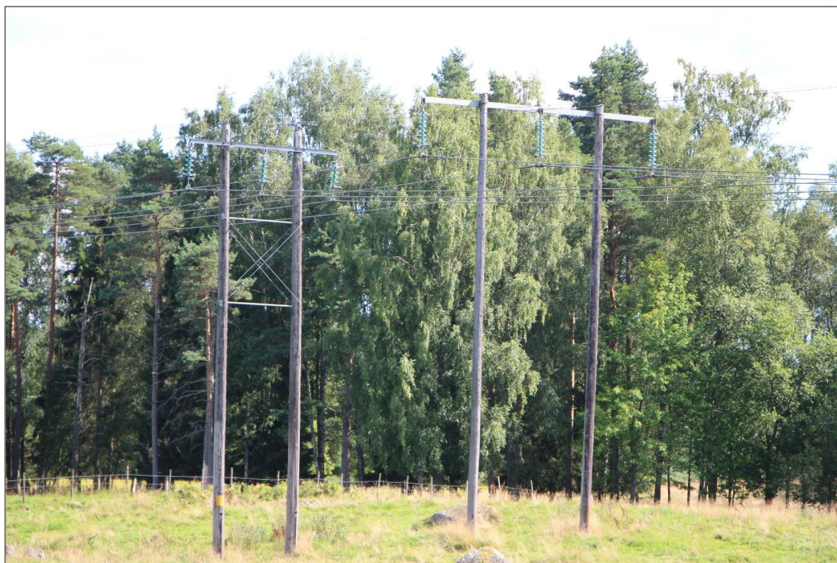
Figur 10. Vanliga stolptyper i regionnätet med spänning 50-150 kV med horisontellt orienterade faslinor. Till höger en dominerande stolpe i 130 kV-nätet. Till vänster en motsvarande stolpe med 50 kV. Detta är portalstolpar med stolpben i impregnerat trä, nedhängande isolatorer och vanligen två topplinor. Avstånden mellan strömförande delar är vanligen stort.
