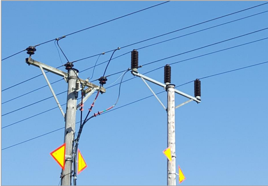
Figur 11. Ovan så kallad linepost stolpe eller enbent trästolpe med upprättstående stödisolatorer. Till höger en stolpe i regionnätet. Till vänster motsvarande konstruktion på lokalnätsledning där isolatorerna inte är lika höga. Avstånd i vertikal led från regeln upp till faslinan är på regionledning vanligtvis ca 60 cm på 40–50 kV stolpe och på lokalnätsstolpe ca 20 cm.
