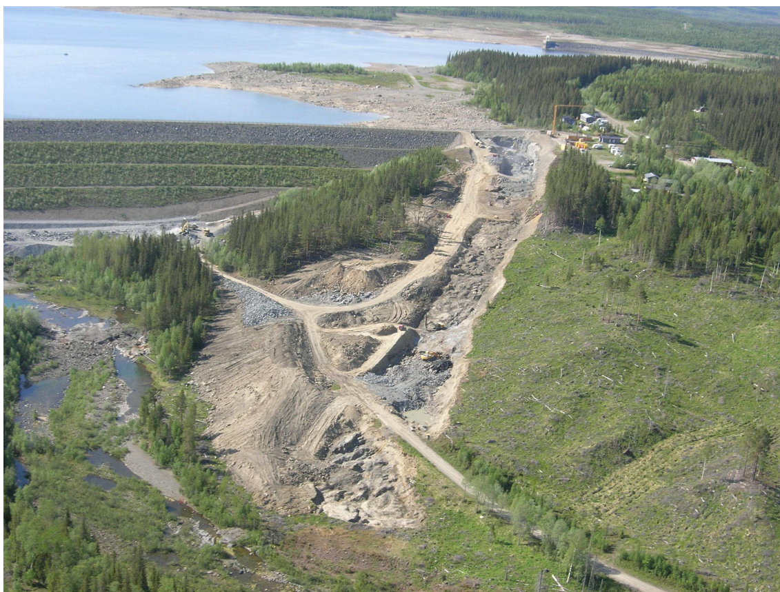
Figur 5. Ombyggnadsarbeten för att förse Håckrendammen med ett nytt utskov och därigenom ytterligare höja säkerheten. (Foto: Vattenregleringsföretagen, 2006)
